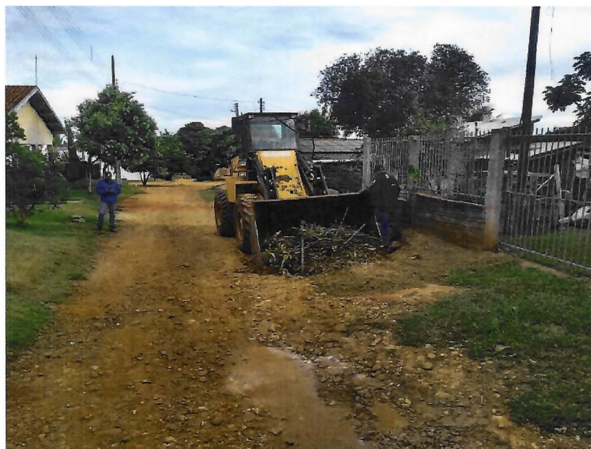
Figura 07: Pá carregadeira Fonte: Prefeitura Municipal de Mirador
