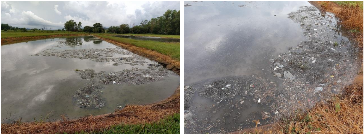
Figura 113: Resíduos grosseiros na lagoa de tratamento de esgoto na ETE de Terra Rica.
