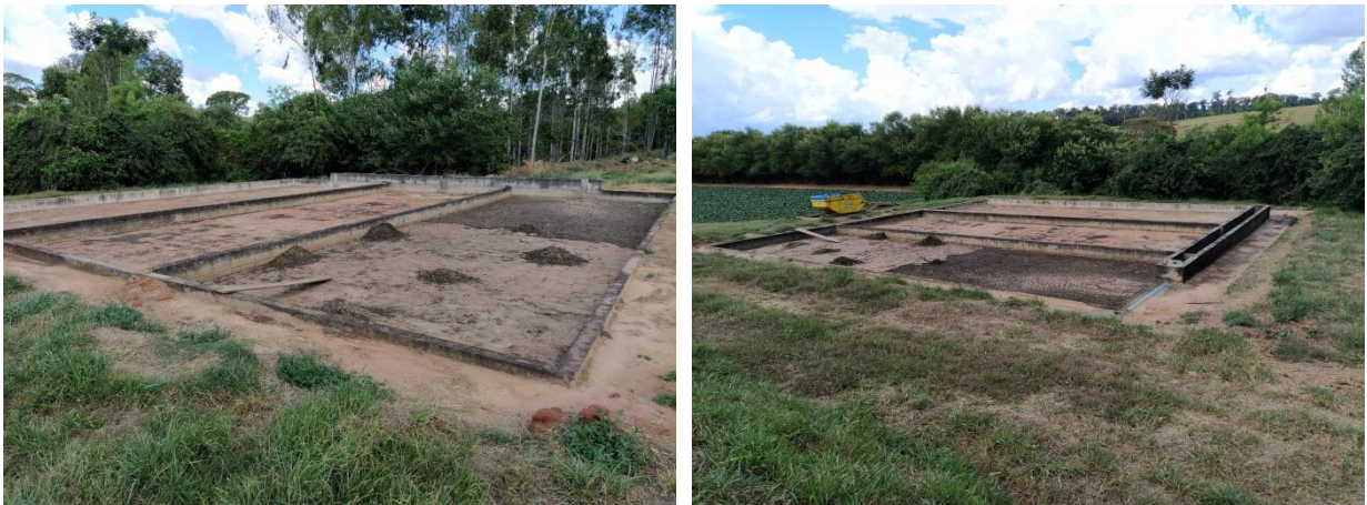
Figura 111: Leito de secagem de lodo na ETE São João do Caiuá.
