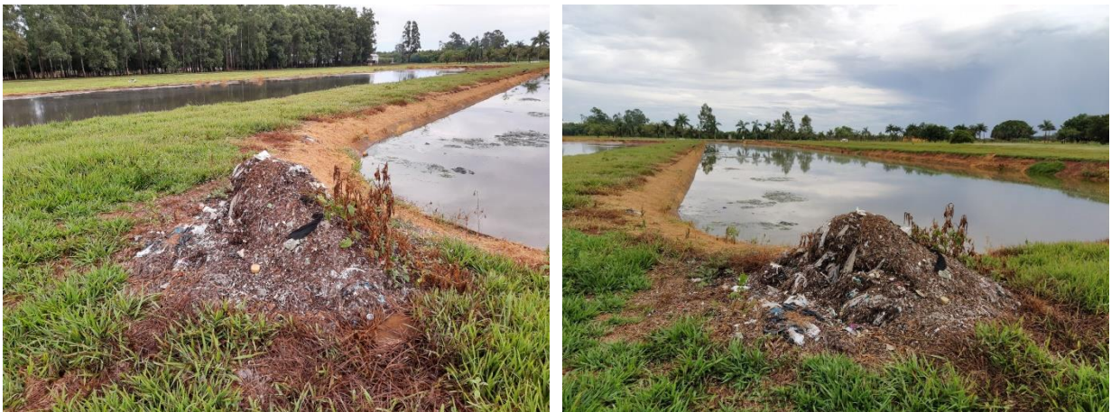
Figura 114: Armazenamento de resíduos grosseiros ao lado da lagoa de tratamento de esgoto na ETE de Terra Rica.
