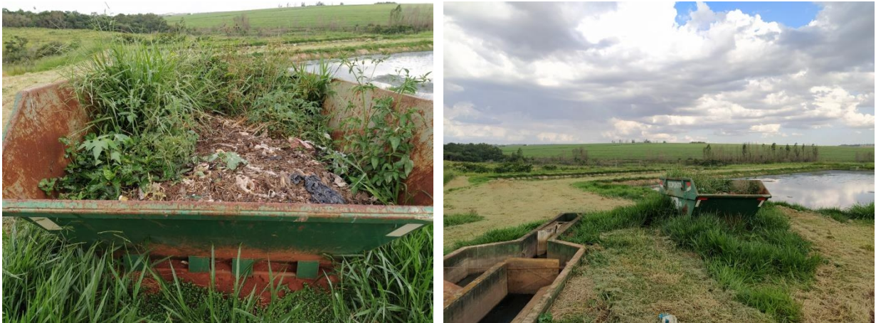
Figura 112: Armazenamento de resíduos de gradeamento e desarenador na ETE de Presidente Castelo Branco.
