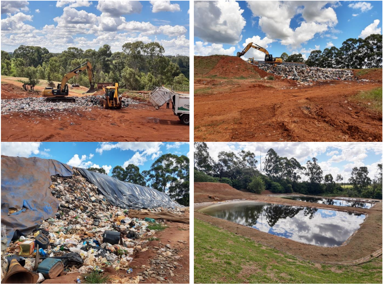
Figura 93: Aterro sanitário do município de Paranavaí.
