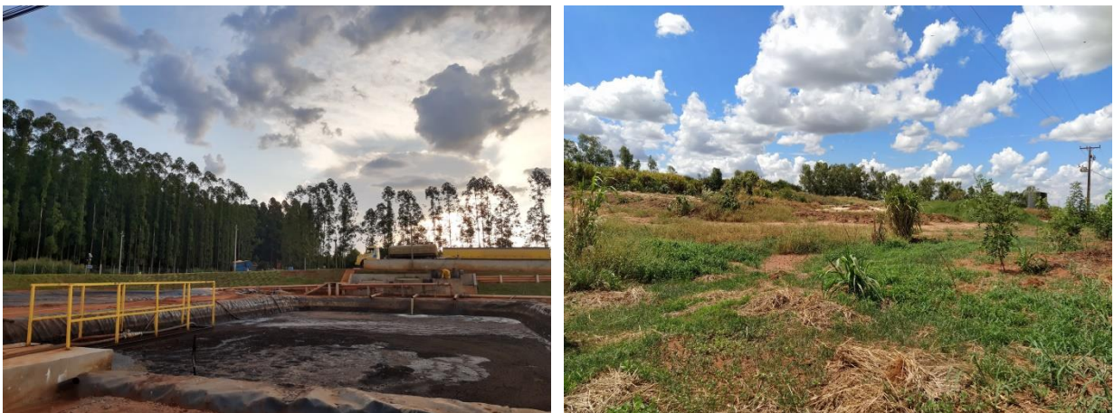
Figura 127: Empresa de tratamento de efluentes industriais em Presidente Castelo Branco (a esquerda) e de resíduos industriais em Cruzeiro do Sul (a direita).
