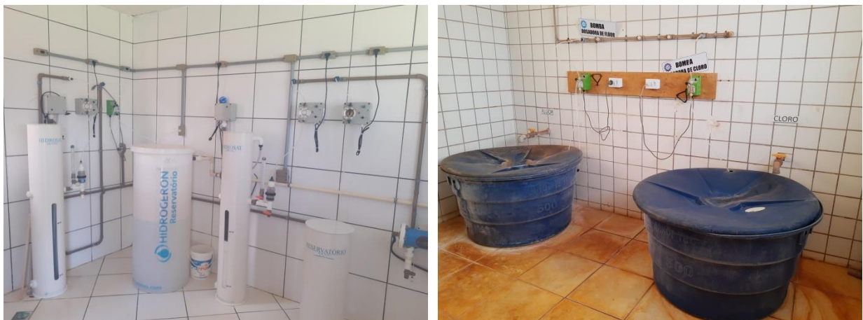
Figura 110: Processo de cloração e fluoretação do SAA de Paranaipoema (à esquerda) e Presidente Castelo Branco (à direita).
