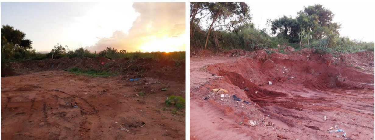
Figura 103: Área em processo de licenciamento para Aterro Classe II B, em Presidente Castelo Branco.
